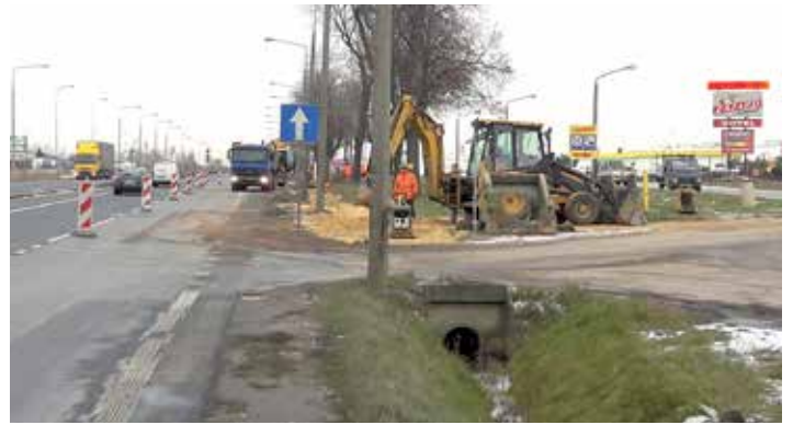
• Budowa chodnika w Wielogórze łączącego przystanek autobusowy linii A przy hotelu „U Grubego” z ulicą Ceglana.
