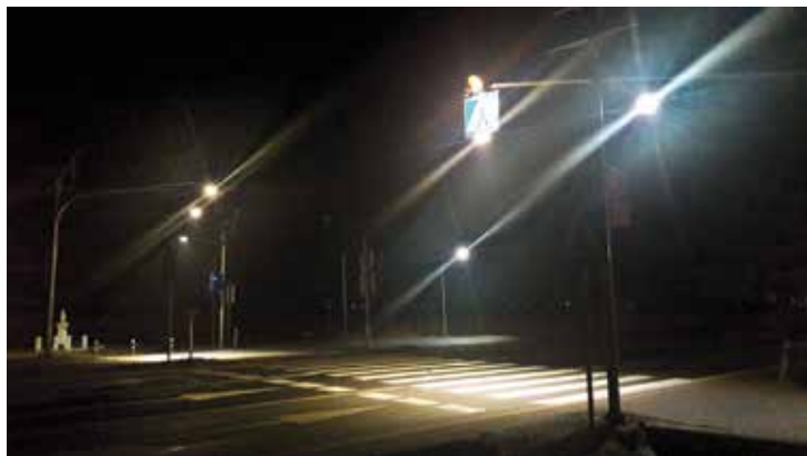
● Oświetlone przejście dla pieszych we Wsoli poprawiło bezpieczeństwo.
