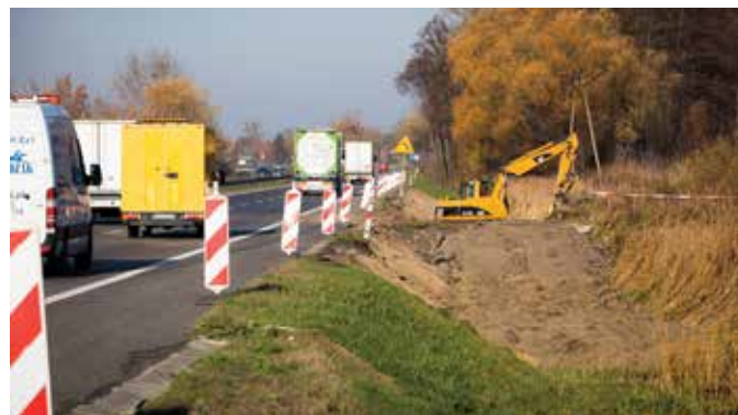
Budowa ścieżki rowerowej Jedlińsk - Wsola W trakcie realizacji
