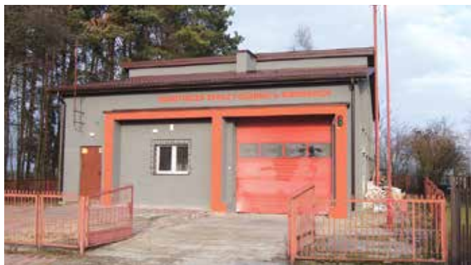
Remont dach strażnicy OSP w Bierwcach Wartość: 72.600,02 zł
