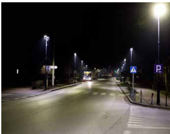
Wymiana oświetlenia ulicznego na LED - II etap W TRAKCIE REALIZACJI Wartość: 3.199.783,50 zł
