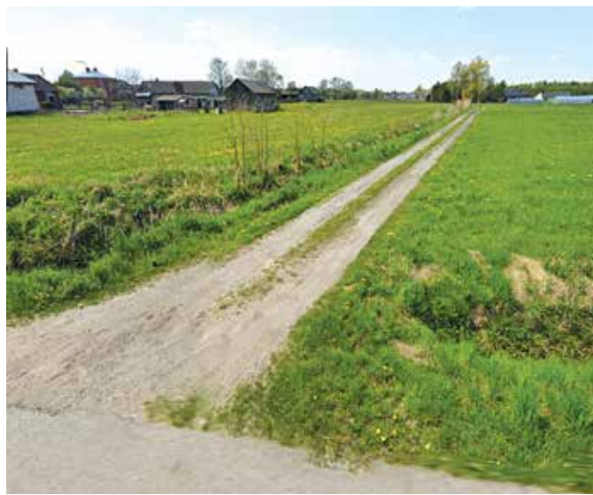
Budowa drogi w Płaskowie W TRAKCIE POSTĘPOWANIA PRZETARGOWEGO Wartość szacunkowa: 1.700.000,00 zł
